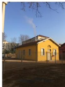
4 Chaufferie CROUS et accès possible depuis la ruelle du grand casernement
