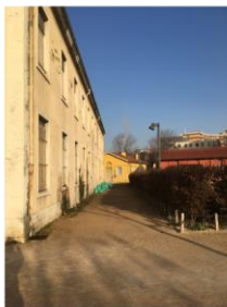
3 Bande de terrain entre le bâtiment et le service espaces verts
